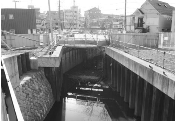
石神井川改修工事 (東伏見1丁目)
