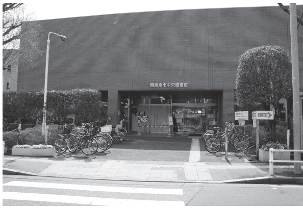
田無駅近くにある「中央図書館」(南町5丁目)
