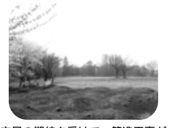
市民の期待を受けて、築造工事がはじまる(仮称)合併記念公園
