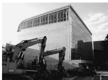
平成18年5月オープンに向けて建設が進む(仮称)西東京市体育館
