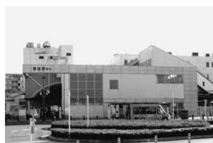
都市計画道路西3・4・15号線が接続する保谷駅北口
