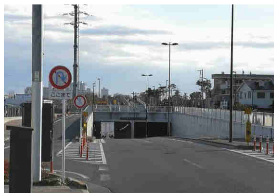
市内の立体交差
