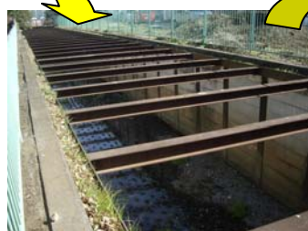
矢板による護岸 (弥生橋付近)
