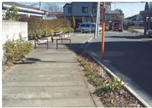
白子川支川(暗きょ)（下保谷付近）
