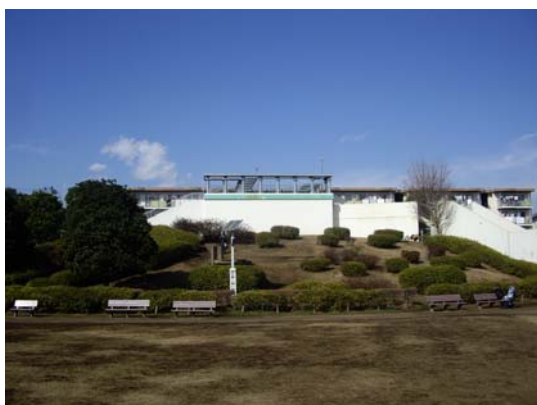
上部を公園として有効利用している 東町ポンプ場
