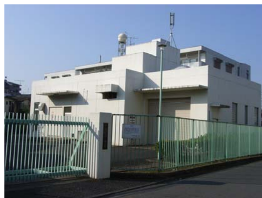
下保谷ポンプ場
