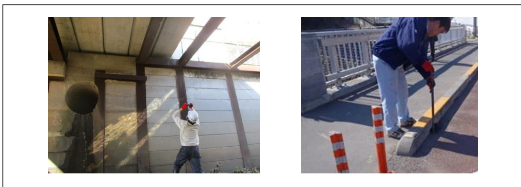
写真 4.2 日常の維持作業状況
