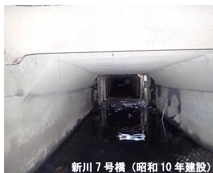
写真 2.1 最も古い橋梁（88 年が経過）
