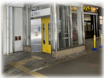
エレベーター（保谷駅南口）
