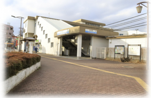
東伏見駅南口
