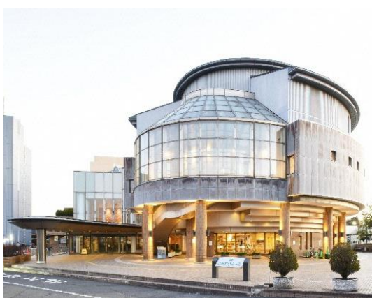
▲保谷こもれびホール
