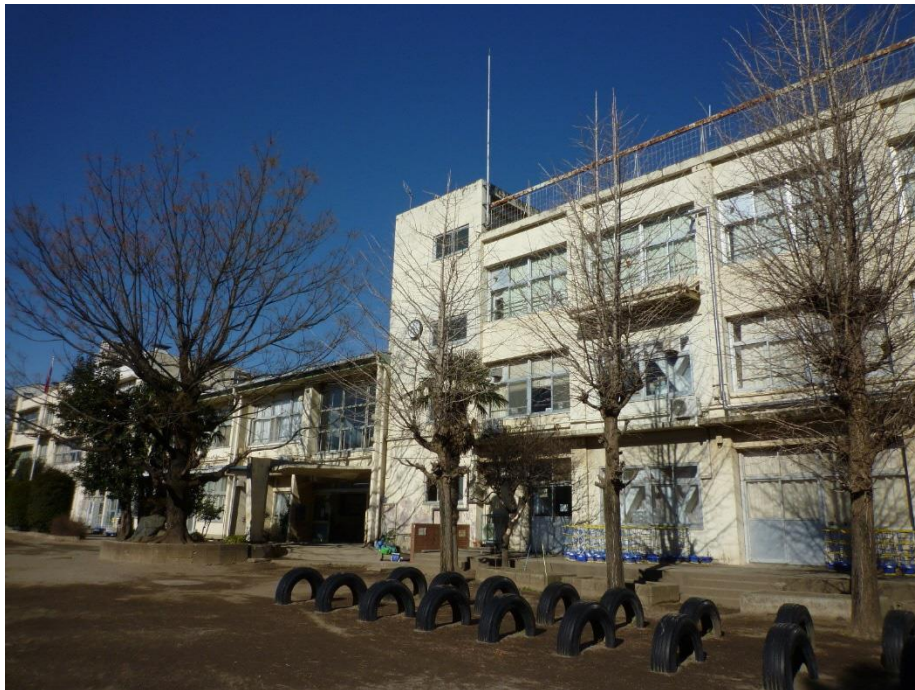
建替工事を実施する中原小学校（2021年竣工予定）
