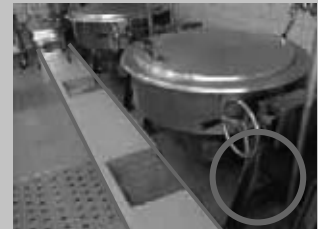
適切な位置にグレーチングを整備した。
