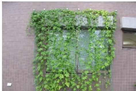
東伏見コミュニティセンター
