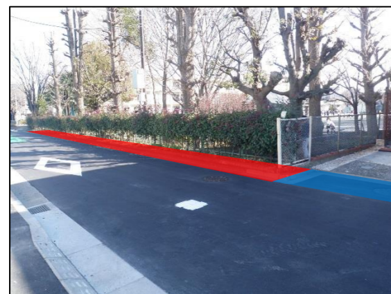
写真1 市道 2272 号線東側
