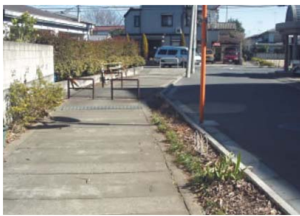
白子川支川(暗きょ)（下保谷付近）
