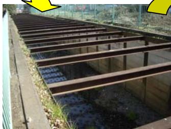
矢板による護岸 (弥生橋付近)
