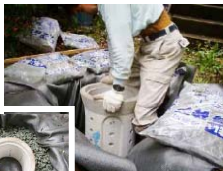
【ますの設置状況】
