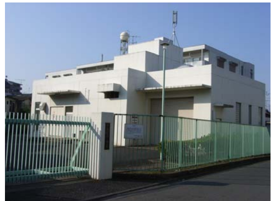
下保谷ポンプ場
