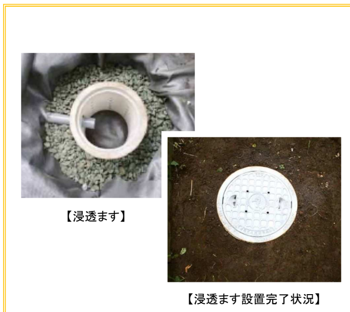
図 4-9 浸透ます設置状況
