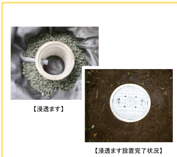
図 4-9 浸透ます設置状況
