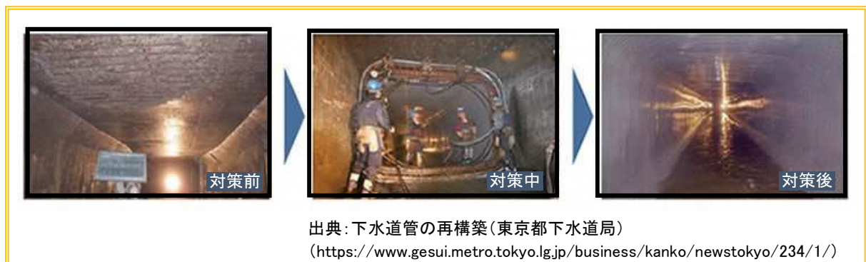
図 4-6 下水道管の更生工法*
