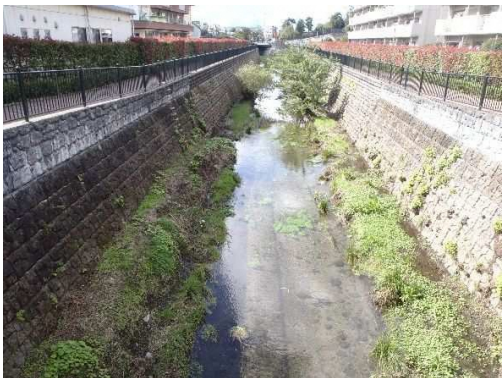
現在の石神井川 (弥生橋付近)
