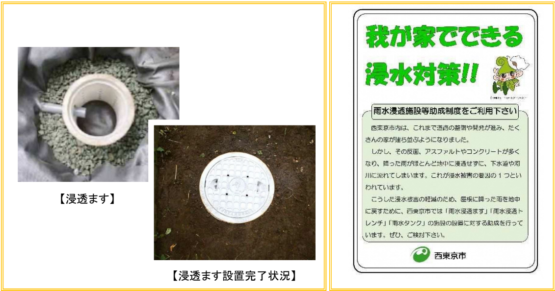
図 4-9 浸透ます設置状況
