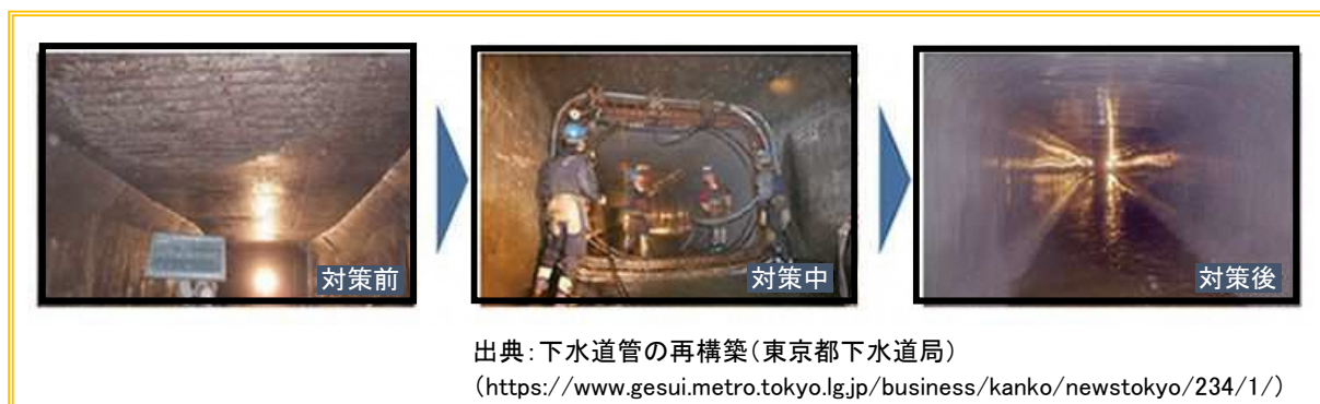
図 4-6 下水道管の更生工法*
