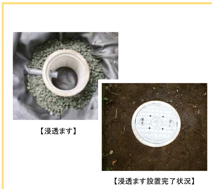
図 4-9 浸透ます設置状況
