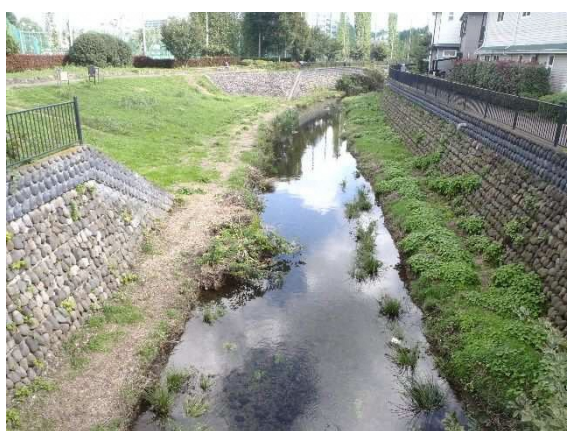
石神井川の親水化と周辺のみどりを活かした 景観形成（東伏見小学校下流）
