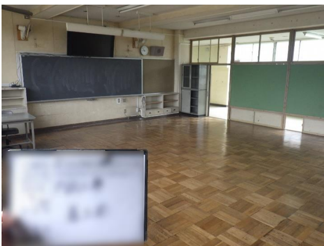
施工前（普通教室）
