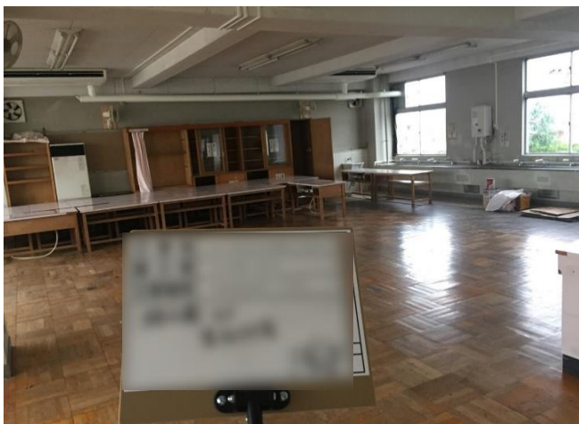
施工前（家庭科室）
